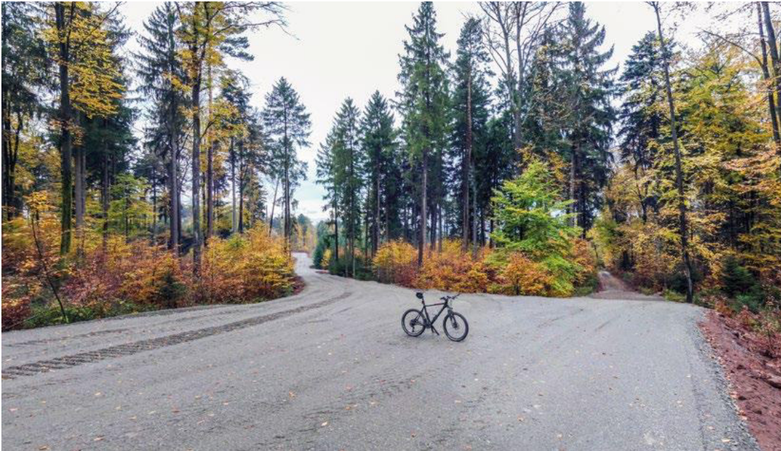
Dauerhafte Flächenversiegelung: Zufahrt zum Bau von Windenergieanlagen, Foto: Joachim-Wasserthal
